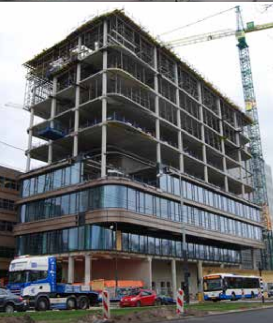
Amsterdam Zuid, Strawinskylaan, aanbouw Atrium Noord
