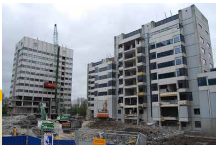
Amsterdam Zuid, Parnassusweg 224, sloop tbv nieuwbouw Gerechtshof
