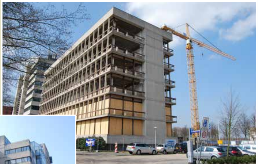
Amsterdam Nieuw-West, Jan Tooropstraat 101 en Van de Sande Bakhuisenstraat 6, wonen en sloop tbv woningbouw
