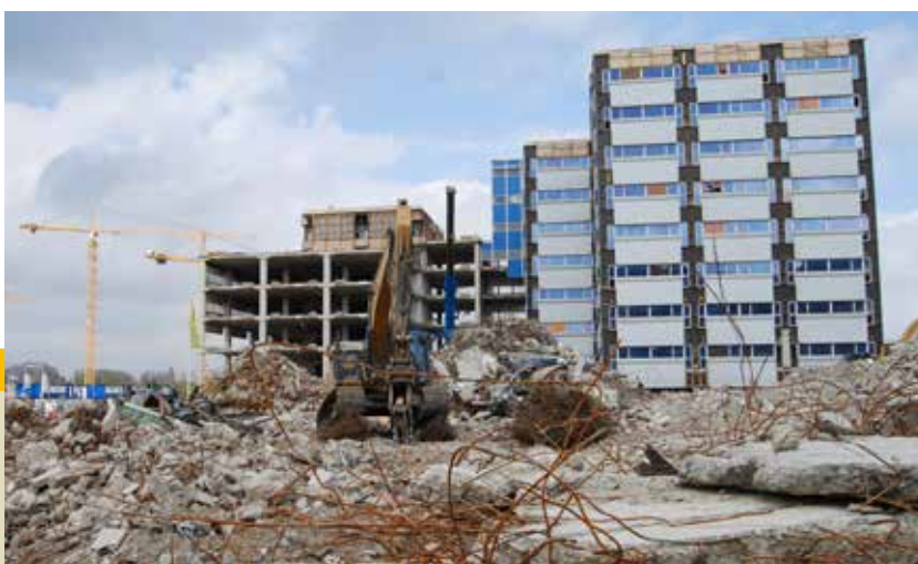
Diemen, Eekholt 24-32, sloop tbv woningbouw
